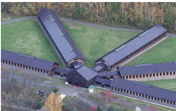
博物館網走監獄(重要文化財 舎房及び中央見張所)
