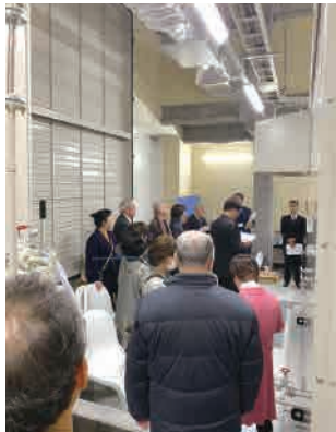
2階 防災室・発電機など
