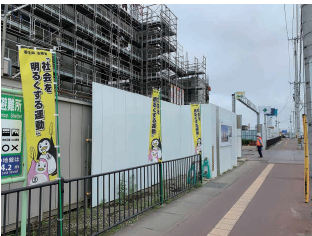
筒井小学校建築現場
